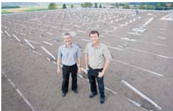
484 Solarpanels werden in Büren Strom produzieren. Armin Zingg (links) und Thomas Peter auf dem Dach der Bruno Peter AG. Bild: os
